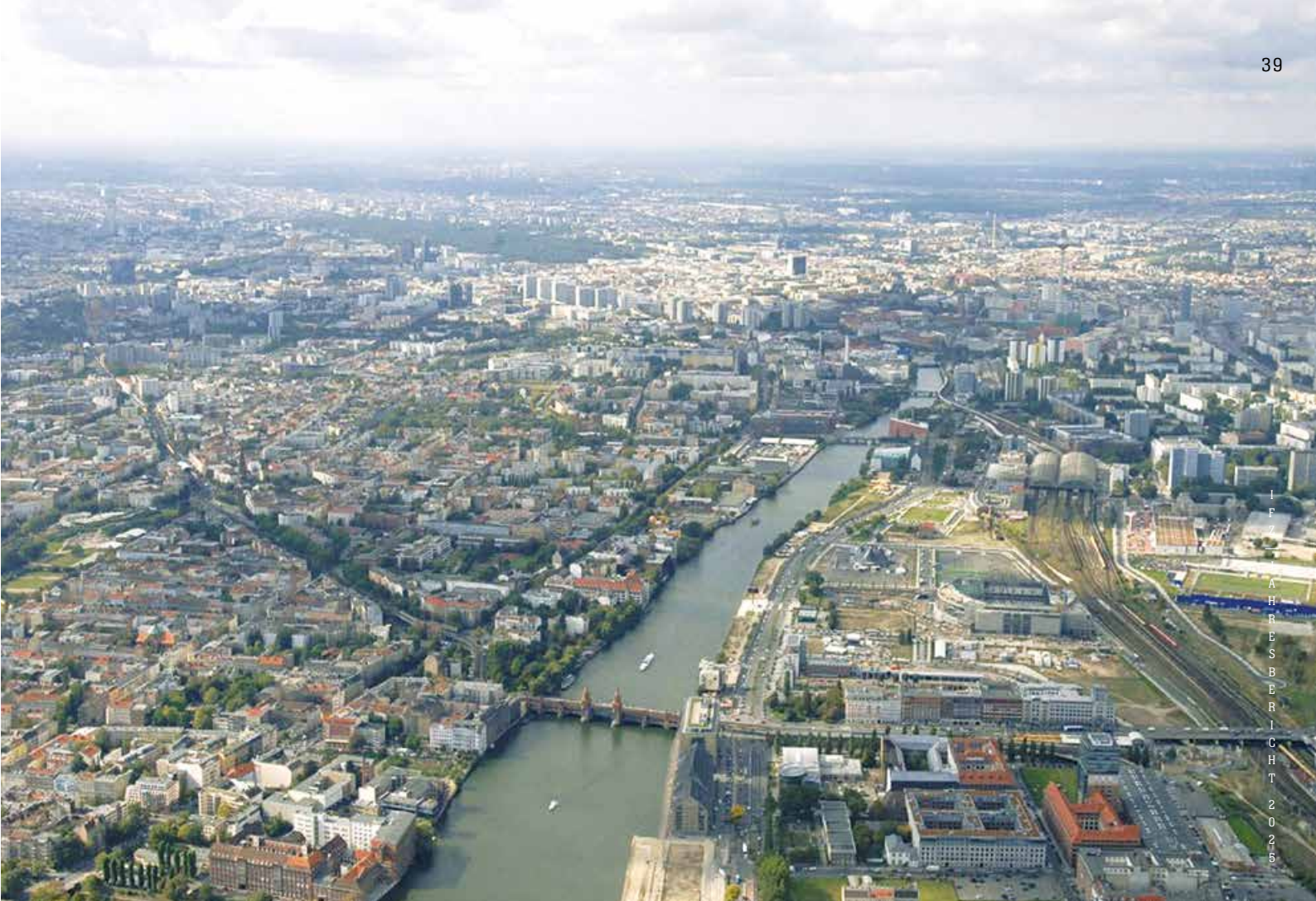
Auf dem ehemaligen Werksgelände des DDR-Glühlampenkombinats NARVA in Berlin-Friedrichshain ist das Dienstleistungsquartier Oberbaum-City entstanden.
