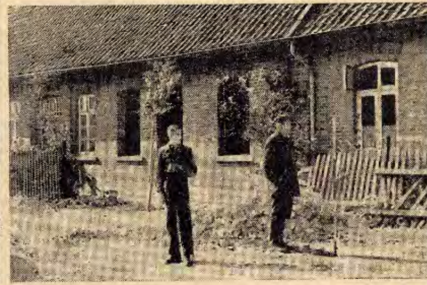
Hier schlitze ein Pontonfahrzeug eine Wohnhauswand auf
