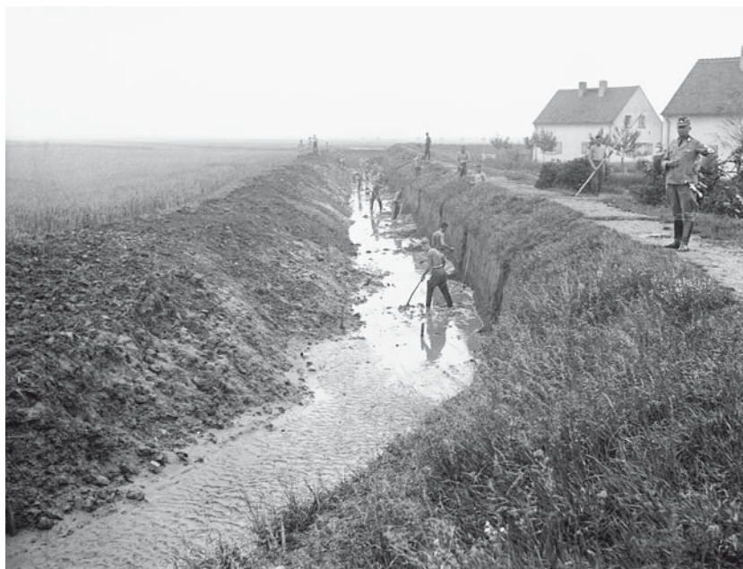
Abb. 4: Wasserwirtschaftliche »Landeskulturarbeiten« des RAD in der Oberrheinischen Tiefebene (bei Worms), 1938, rechts ein RAD-Führer mit »Führerdolch« (BArch, Bild 133-300).
