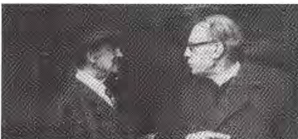
Im Heizungskeller des Präsidentenpalais Leferenz befragt den Zeugen Grunewald über die Zugänge zum Heizungskeller, über die technischen Anlagen, über seine Feststellungen und die Beobachtungen seines Heizerkollegen Wittkowski.
