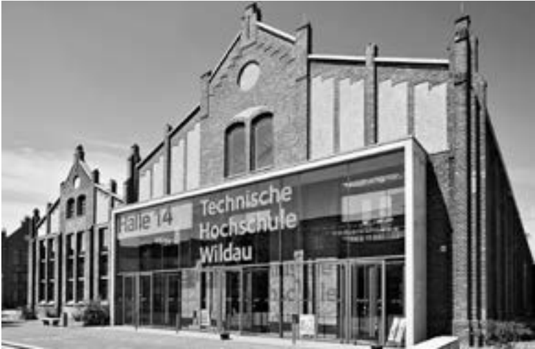
Abbildung 11: Hauptgebäude der TH Wildau in einer ehemaligen Produktionshalle des Schwermaschinenbau
