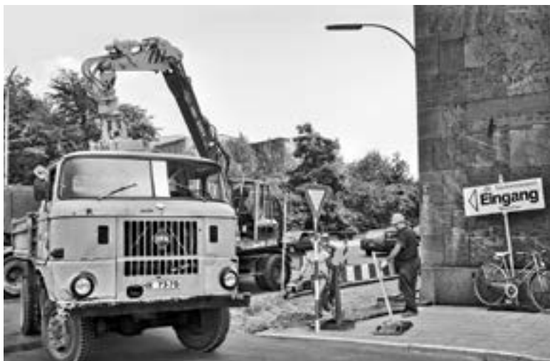
Abbildung 15: Ein IFA-Lkw W50 bei Bauarbeiten im Juli 1991 vor der Zentrale der Treuhandanstalt
