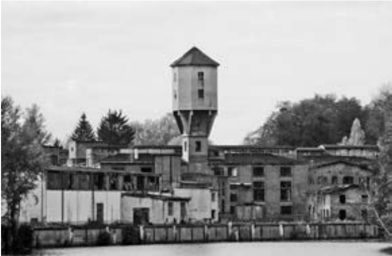
Abbildung 19: Denkmalgeschützte Ruine der Papierfabrik Wolfswinkel 2013
