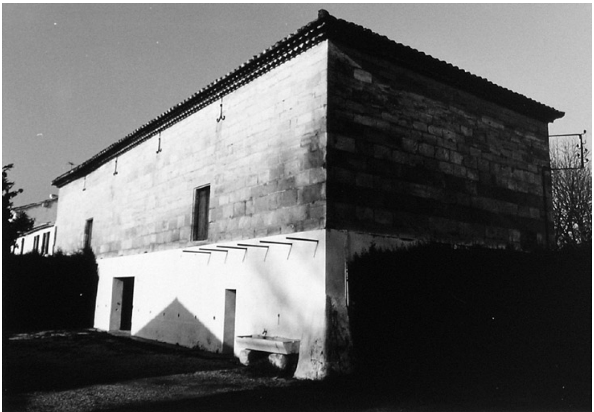
Duroure: Nebengebäude (Foto der 50er)
