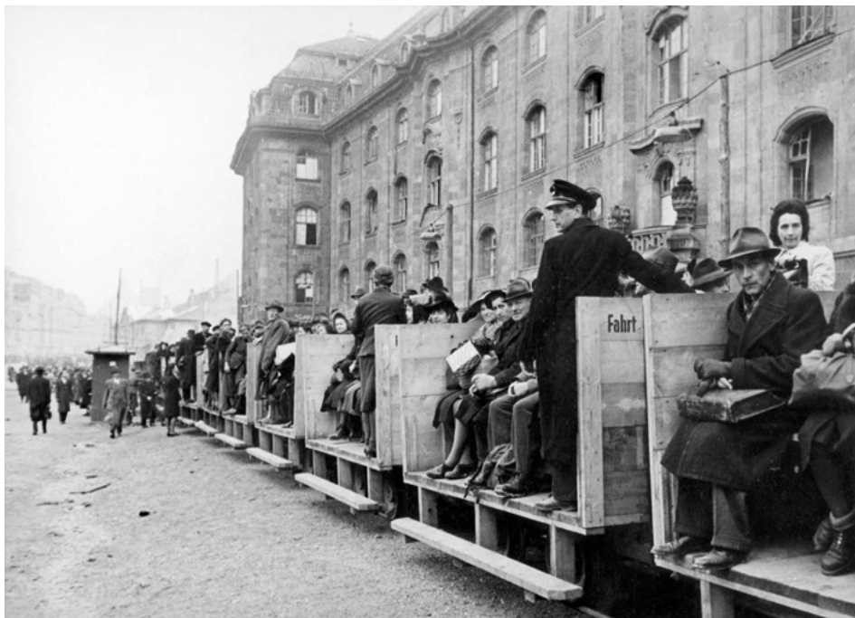
Abbildung 19: Münchner Behelfsbahn, ca. 1944
