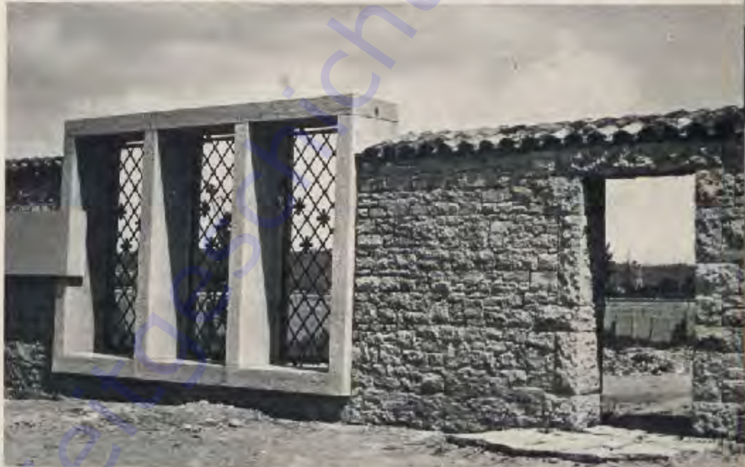
Drei schmiedeeiserne Gitter unterbrechen das Mauerwerk und erlauben einen Durchblick auf das Gräberfeld
