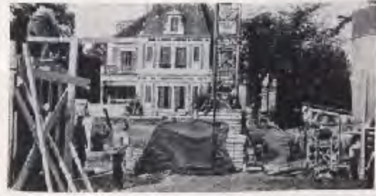
Die Baustelle befindet sich in St. Cyr au Mont d'Or unweit Lyon.
