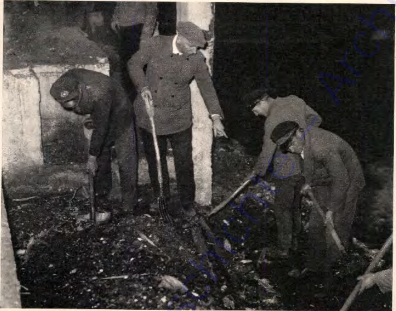
Nach zehn Minuten war der Plenarsaal ein einziges Flammenmeer. Aufräumarbeiten im Reichstag
