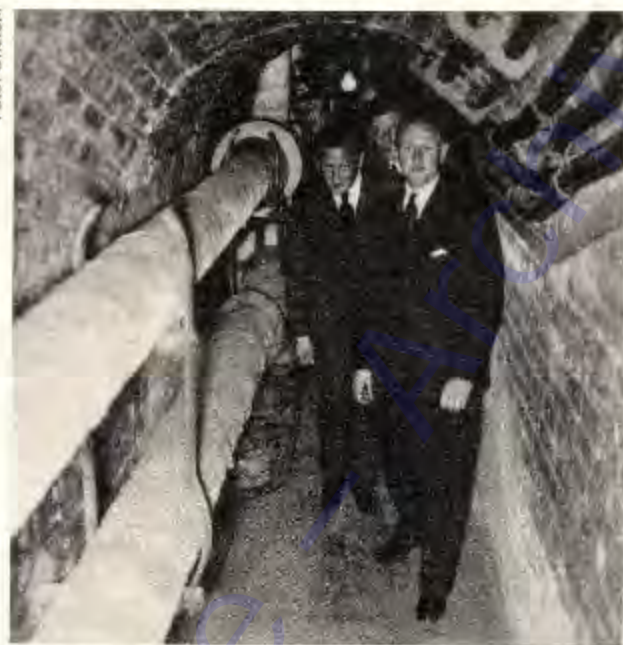
Lokaltermin im Heizungstunnel zwischen Kesselhaus und Reichstag: Ist das Zündmaterial für die Brandstiftung durch diesen Gang herbeigeschafft worden?
