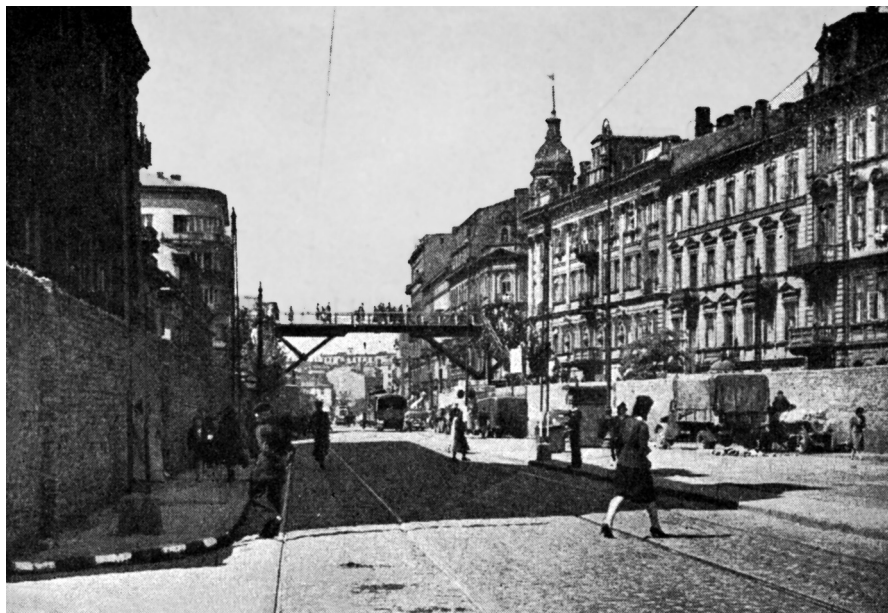
Abbildung 16: Die Verbindungsbrücke zwischen den beiden Warschauer Ghettohälften 118
