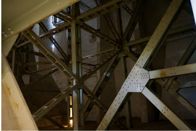
Abbildung 5: Stahlkonstruktion unterhalb der Langemarck-Halle © Tobias Hof
